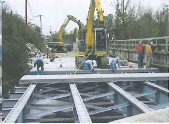
b) Giải pháp sàn FRP được cung cấp cho cầu có nhịp dài
